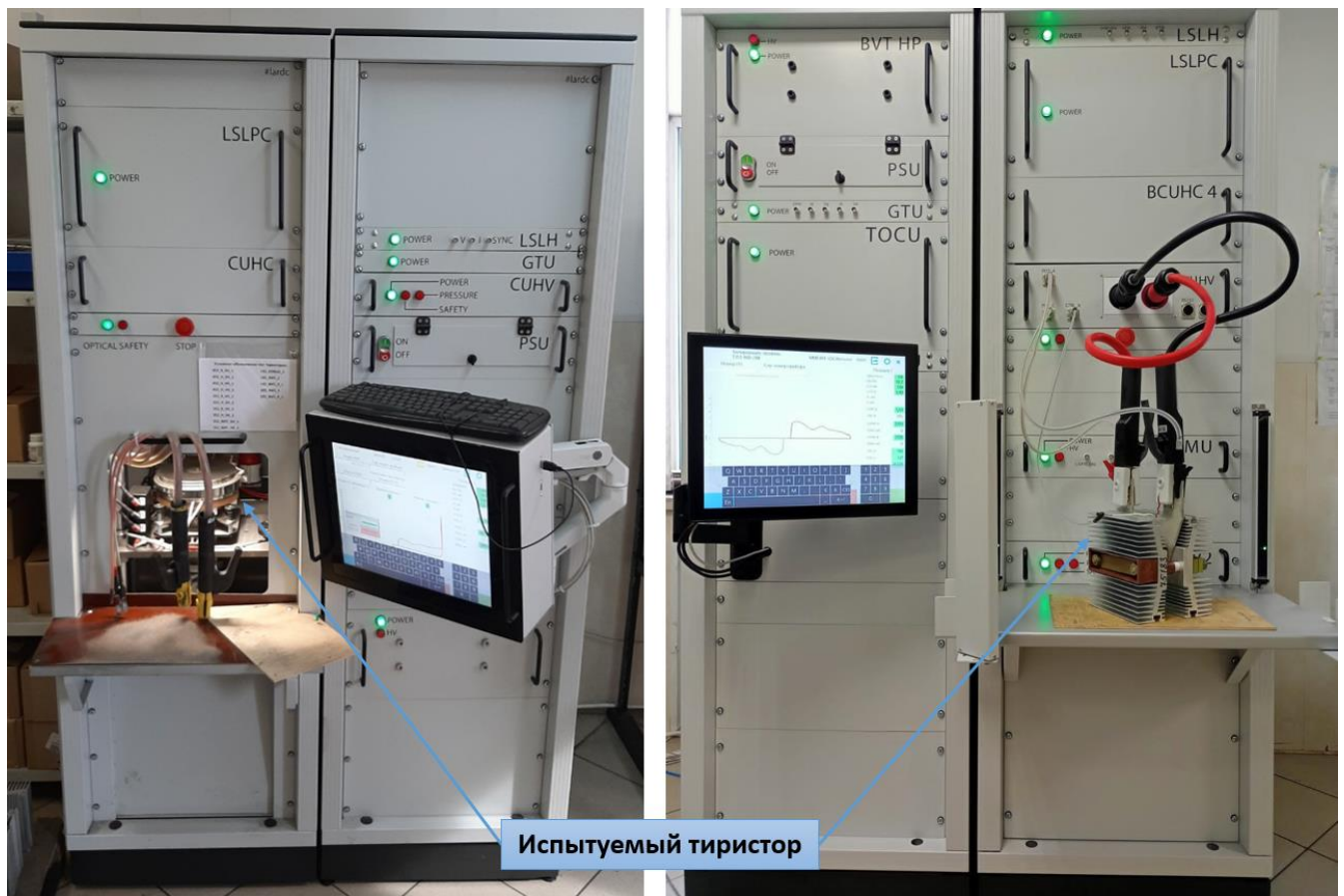
Рисунок 6 – Базовый опорный сервисный центр ремонта ВИП электровозов Восточного полигона в городе Боготоле
