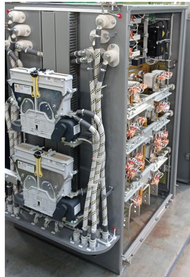
Выпрямитель после ремонта
